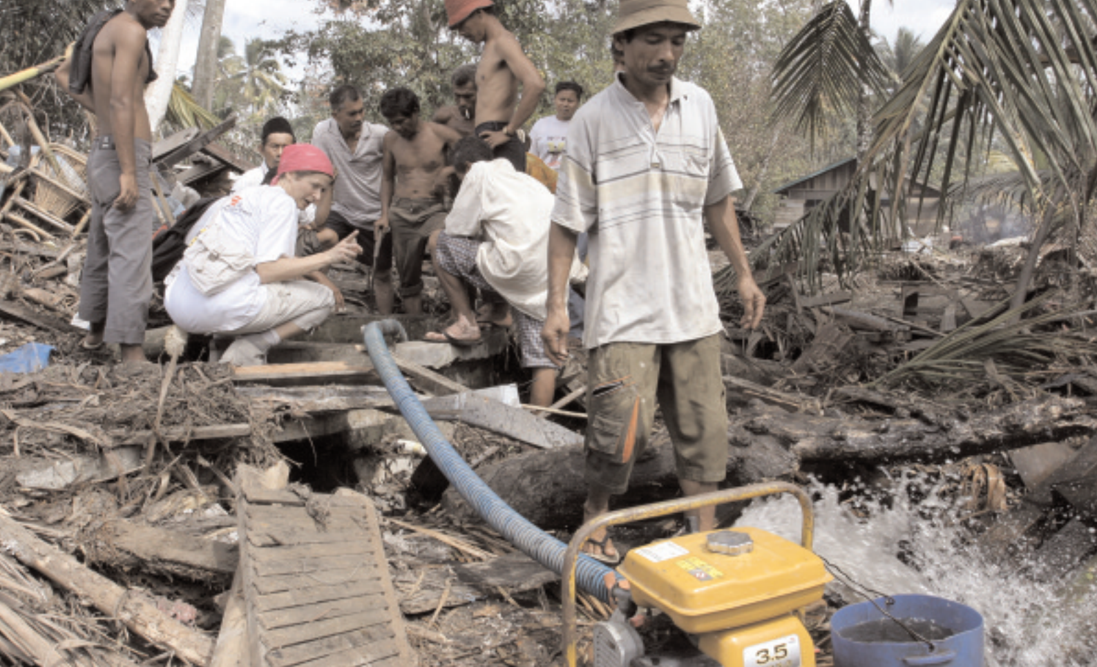
INSTALLERING AV PUMPAR FÖR ATT RENA VATTENBRUNNAR, UTANFÖR MEULABOH, INDONESIA. BILD: STEFAN PLEGER.
