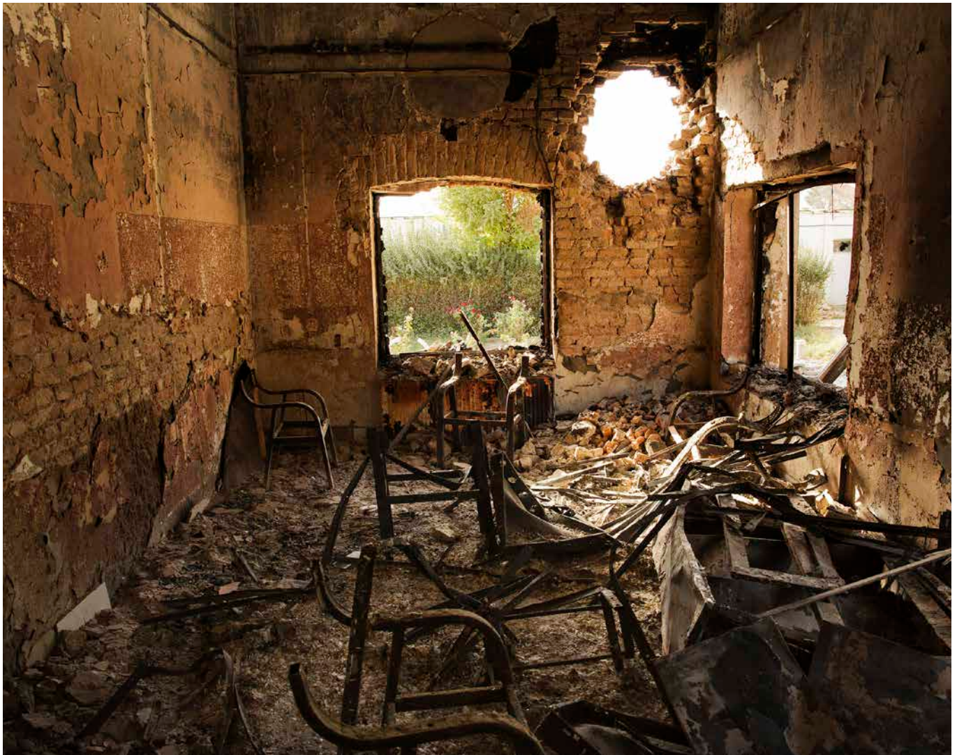
En missil har gjort ett stort hål i väggen till det som en gång var röntgenavdelningen på traumasjukhuset i Kunduz i Afghanistan. BILD ANDREW QUILTY
